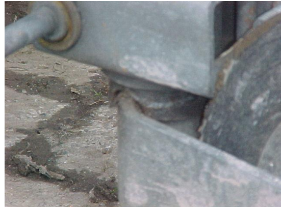
Foto 10: wiel opgesloten en vast!
